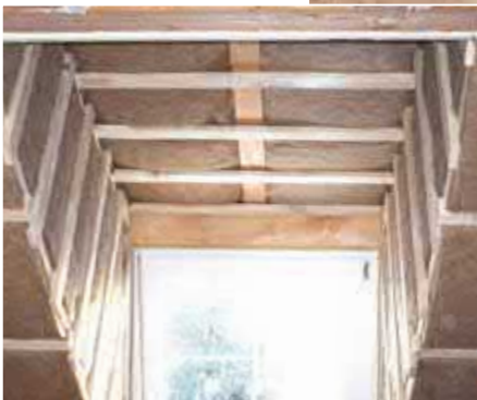
Dämmung eines zum Wohnen ausgebauten Dachgeschosses mit Gaube.
