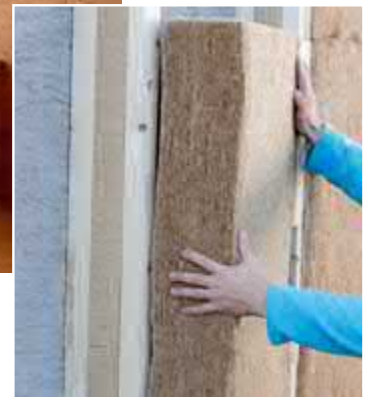
Außendämmung: THERMO FASSADE mit THERMO JUTE 100
