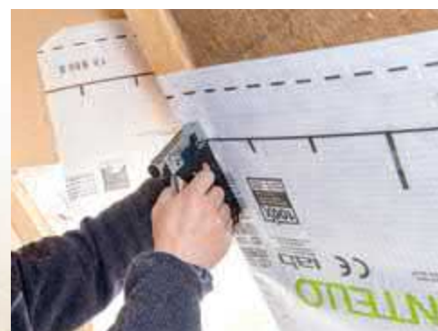
Wichtig ist der fachgerechte Einbau der Luftdichtungsbahnen.
